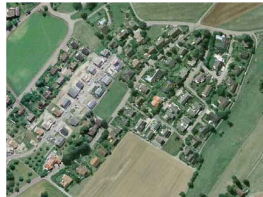
Dezentrale Wohnbauten am Hang: Wenig altersgerecht
